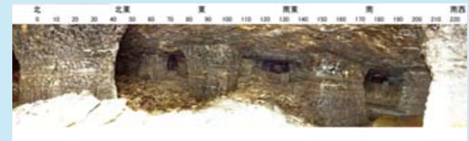
空洞カメラによる地下空洞の画像
