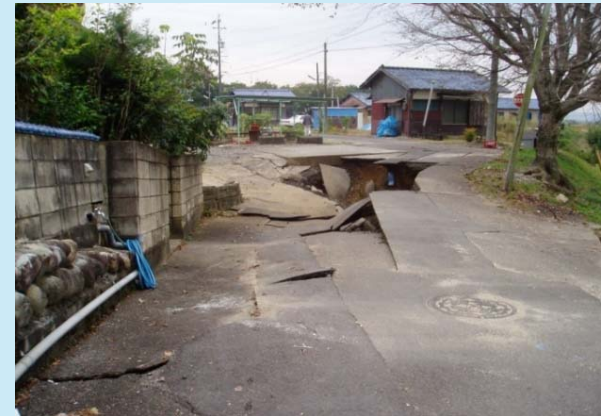
大規模陥没事故 (岐阜県御嵩町)
